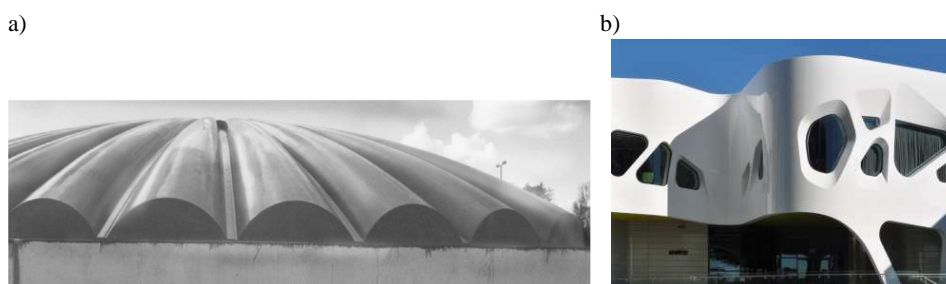
Rys. 2. Przykłady zastosowania kompozytów w budownictwie: a) pokrycie samonośne Dn 15 000, konstrukcja bez podparcia w centralnym punkcie zbiornika, b) fasada budynku Western Australian Institute of Sport
